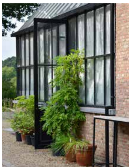
Klinker ist allgegenwärtig als Material für Fassaden und Beläge.
