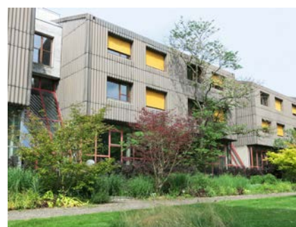
Internat: Hier können Lernende wohnen (i.d.R. Zweierzimmer).
