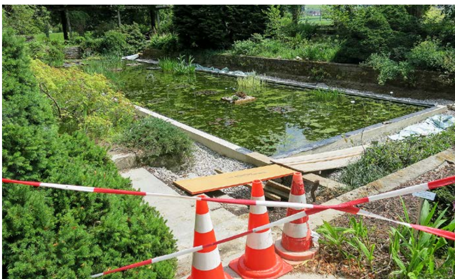
Renovation des Teiches im Senkgarten der GSO. Ein von den Lernenden hoch geschätztes Projekt, weil fast 1:1 wie in der GaLaBau-Praxis.
